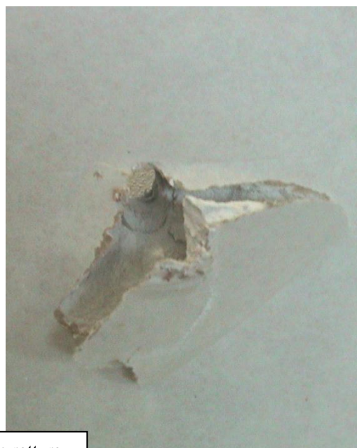
Sfilamento tasselli e rottura cartongesso.
